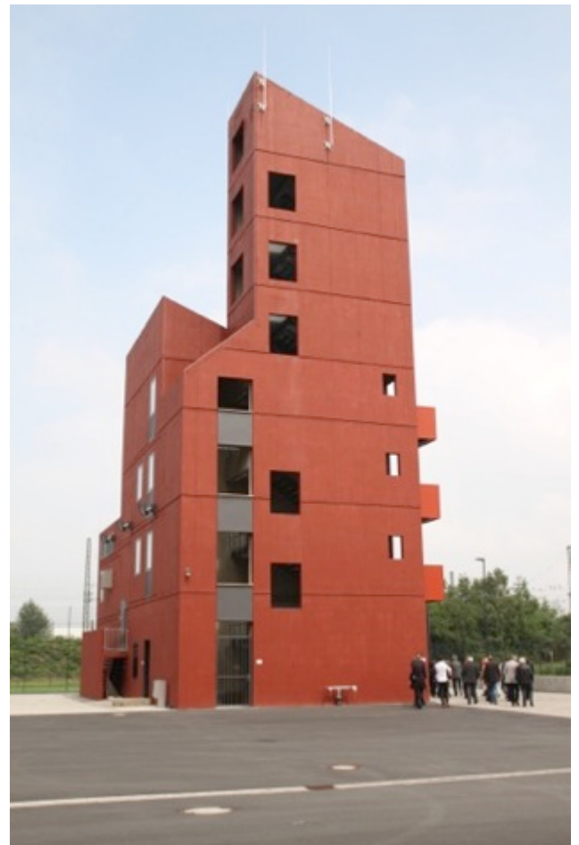
Der 26 m hohe Übungsturm mit diversen Räumen sorgt für optimale Übungsbedingungen
