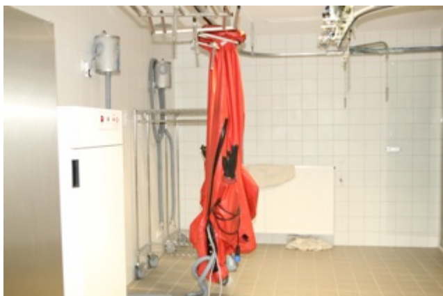
Die Schutzkleidung der Feuerwehr wird in speziellen Räumen gereinigt, getrocknet und geprüft
