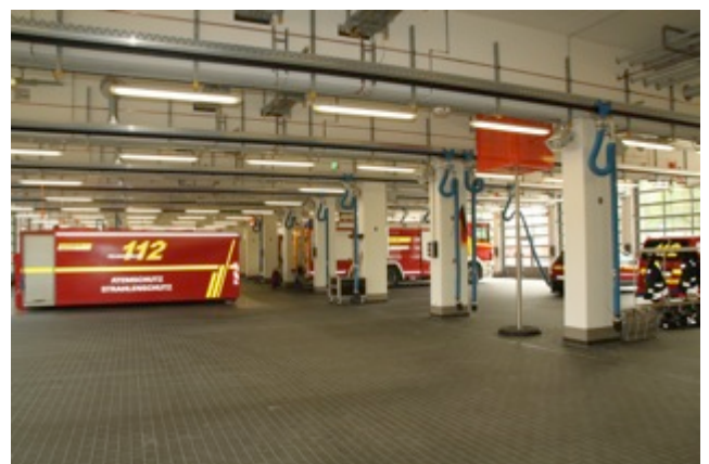
Die Halle bietet u. a. 35 Stellplätze für die Feuerwehr und 12 für den Rettungsdienst
