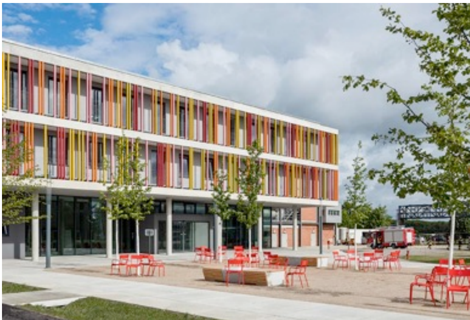
Gebäude mit Seminar- und Übungsräumen sowie Verwaltung
